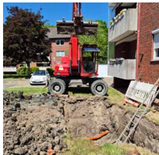
Europaring 59 Erneuerung der Grundleitung Kosten: 6.000 €
