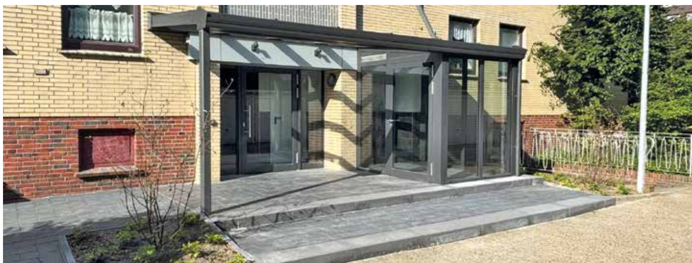
Borkumstraße 22 Modernisierung des Eingangsbereiches Kosten: 60.000 €
