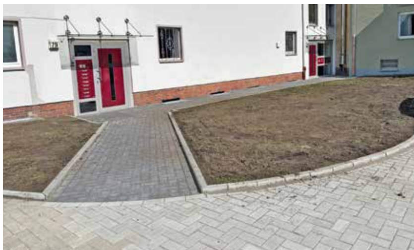
Grenzstraße 79–81 Barrierefreie Zuwegung der Hauseingänge Kosten: 35.000 €
