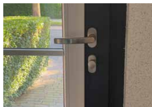
Halligenweg 1–64 Umrüstung der Haustürzylinder auf Knaufbedienung von innen Kosten: 14.000 €
