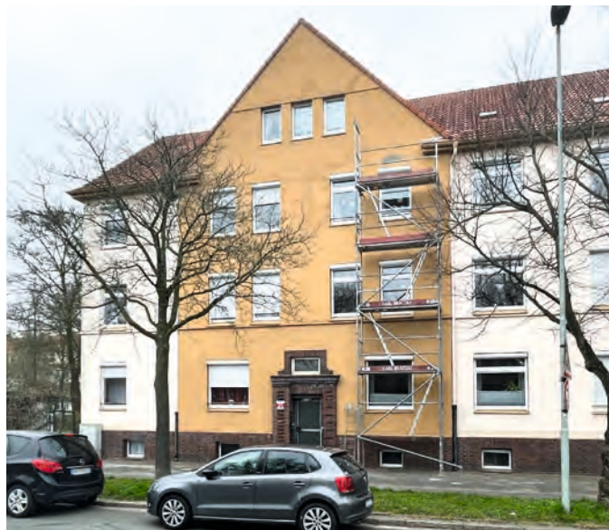
Bismarckstraße 31 Fassadeninstandsetzung Kosten: 10.000 €
