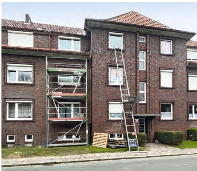
Halligenweg 35 + 37 Sturzsanierung Kosten: 3.000 €
