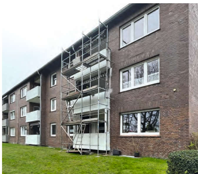
Werdumer Straße 4 Balkonsanierung Kosten: 8.500 €
