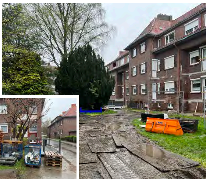
Amrumweg 1 – 5 Neue Balkonanlagen Kosten: 160.000 €
